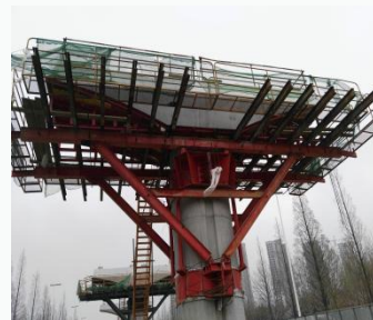
高架桥箱梁模板
