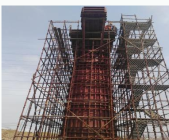
高架桥立柱模板
