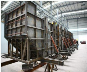
高架桥盖梁模板
