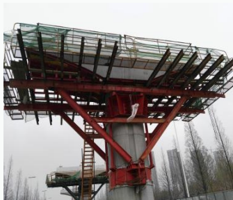
高架桥箱梁模板
