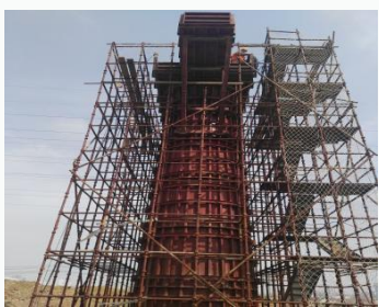
高架桥立柱模板
